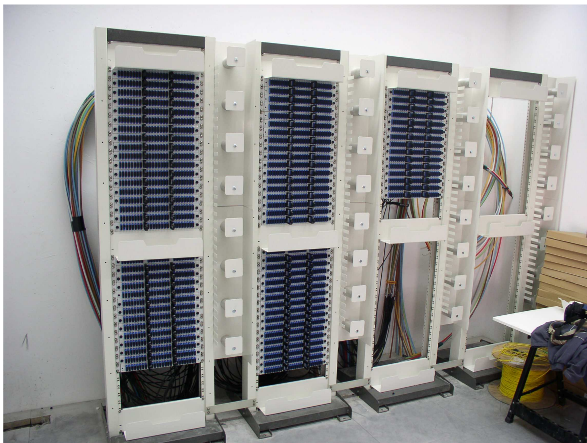
Slika 5. Izvedba centralnog optičkog razdjelnika (ODF)
